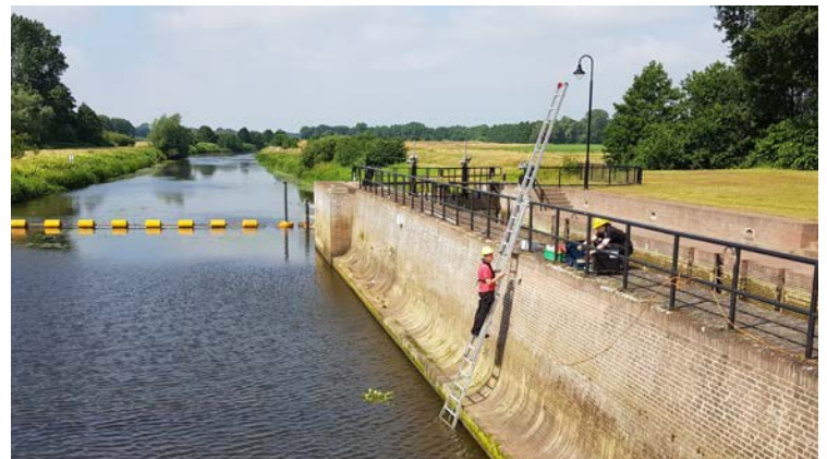
*Het online monitoren van het verplaatsingsgedrag van een monumentale stuw en sluis tijdens renovatie
