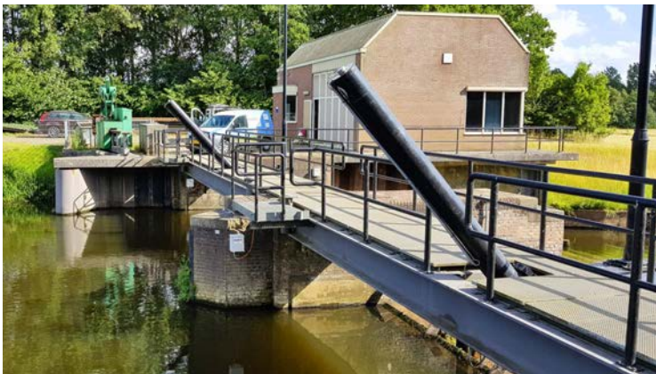
*Het online monitoren van het verplaatsingsgedrag van een monumentale stuw en sluis tijdens renovatie
