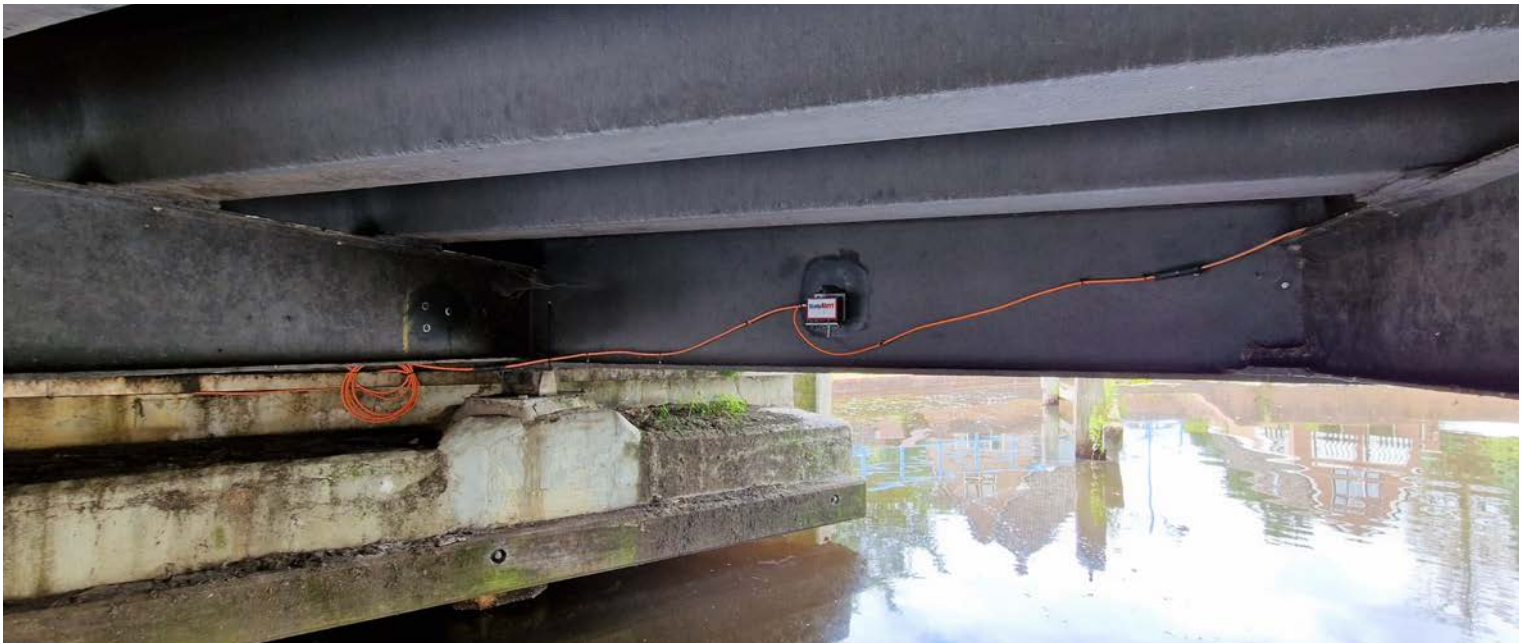
*Online monitoring versnelling en rotatiegedrag in x-y-z- richting van een stalen brugdek
